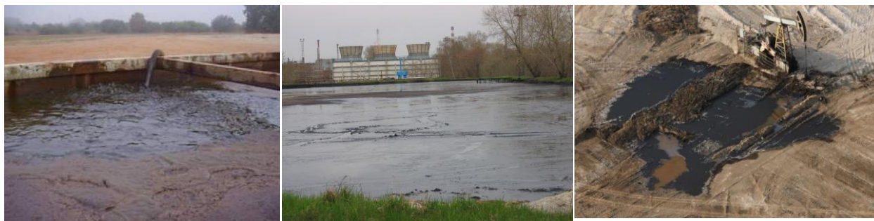
Рисунок 4 – Накопители нефтесодержащих отходов
