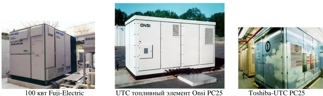
Рисунок 2 – Стационарные электростанции на топливных элементах.
