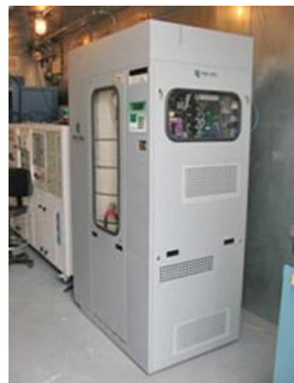
Рисунок 6 Генератор на ТОТЭ в Канаде
